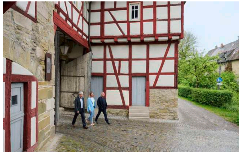
Kleine Ortsrunde: Die Altstadt von Iphofen ist inzwischen perfekt saniert
